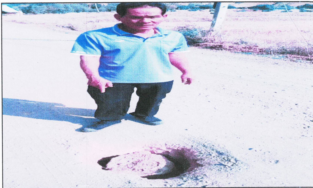
สำรวจเพื่อซ่อมแซมถนนขับไม้แดง บ้านปรางค์มะค่า หมู่ที่ ๓
